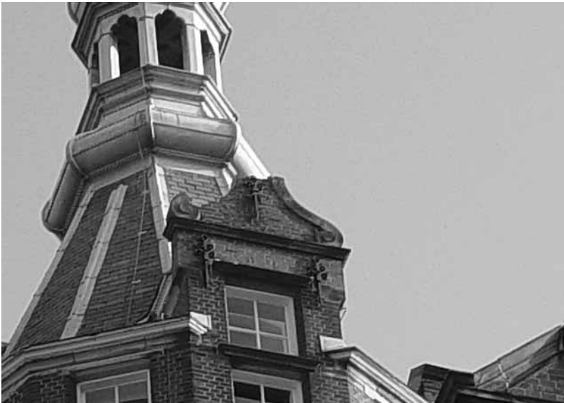
Raamkozijn mee in de vlucht
